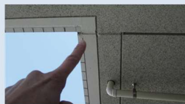
▲シーリングの有無・仕上げの確認
