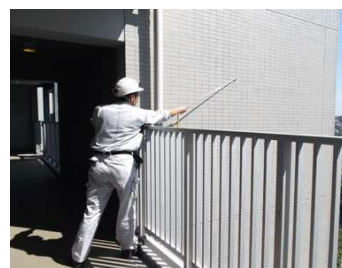
▲マンション共用部点検業務
